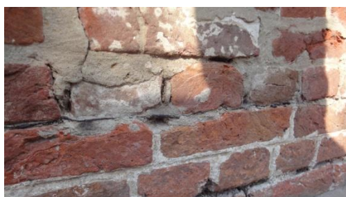
Loszittende voegen dienen hersteld te worden.
