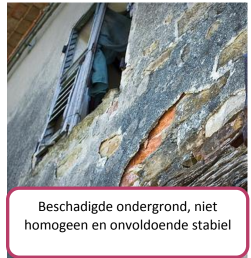
Verflagen in slechte staat, dienen verwijderd te worden
