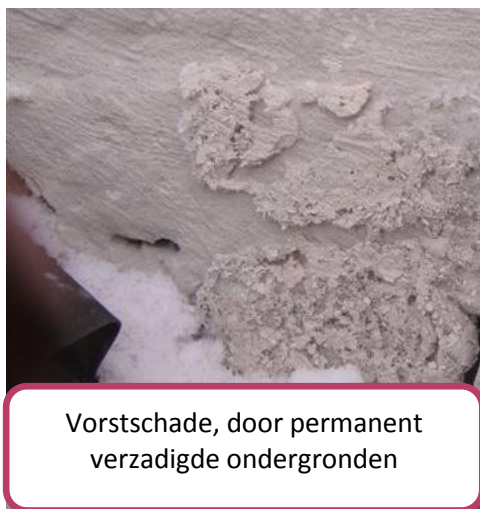
Opstijgend vocht, kalei wordt niet aangezogen en kan resulteren in vorstschade
