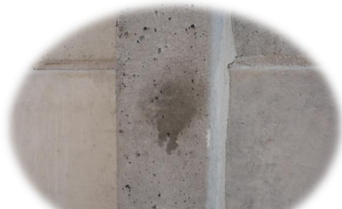
BETONNEN PAAL : Zuigende ondergrond
